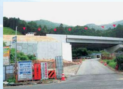
国道23号蒲郡バイパス 五井トンネル付近 8月7日貫通予定
