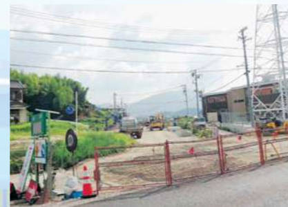
国道247号中央バイパス 王子中村交差点工事状況 来年秋には全線開通の予定
