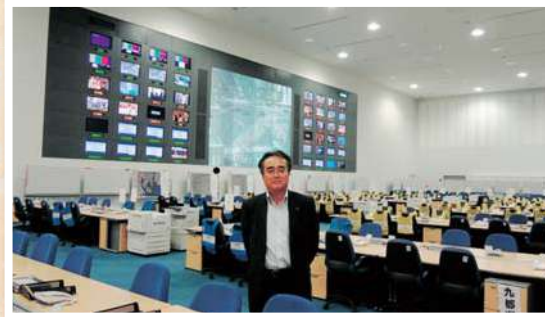
東京湾臨海部基幹的広域防災拠点 有明の丘地区オペレーションルームの調査
