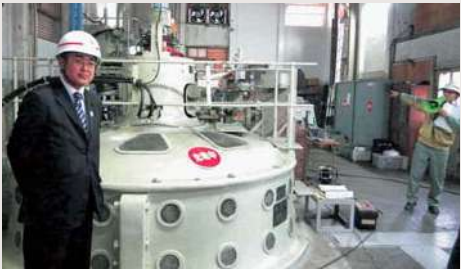
水力発電所調査(中部電力長篠発電所)
