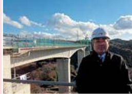
第二東名青木川橋調査
